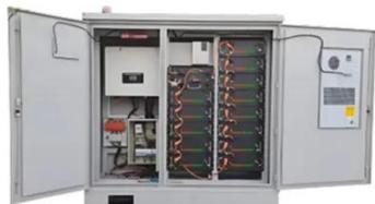
Aug 11, 2017 (solar PV system) شمسية طاقة نظام أي . يتكون من: ١. اللوحة الشمسية- panel solar ٢. المنظم controller ٣. المحول inverter ٤. البطارية...
